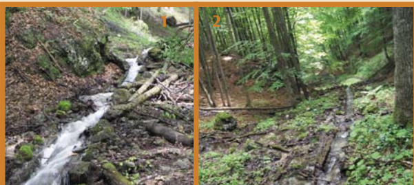
1,2 - stav vodného žľabu pred rekonštrukciou.
